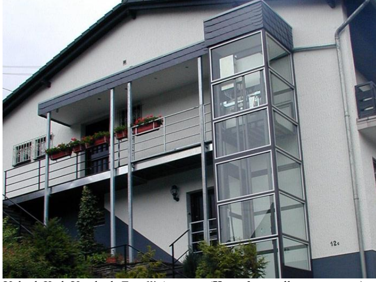
Şekil 4: Yüksek Katlı Yapılarda Engelli Asansörü (Kaynak: engelliasansoru.com)
