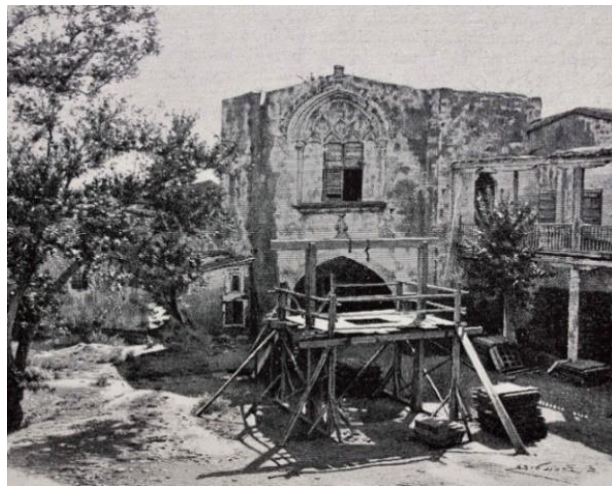
Figure 3.5. Lusignan Palace before demolition (Emile Deschamps, "Quinze mois à l'île de Chypre", Le Tour du Monde, vols 1-2, Paris 1897).
