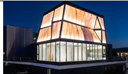
(d) DFAB HOUSE (Dörfler et al., 2019)
