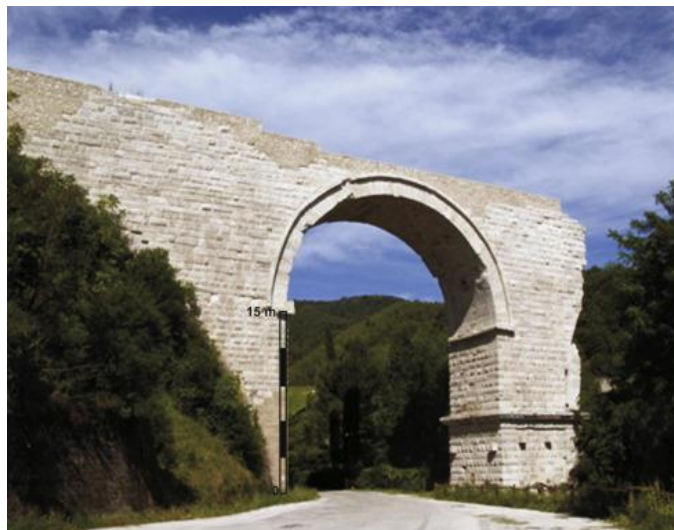
Figure 2.2. Restored Ponte di Augusto (Drdácký et al., 2013).
