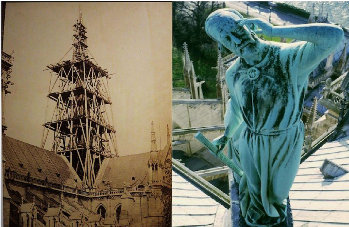
Figure 2.2.12. The spire under construction of the Cathedral of Paris, 1853 / Statue of Saint Thomas on the spire. (Source: Médiathèque de l'Architecture et du Patrimoine / http://hermetism.free.fr/Viollet-le-duc_architecte.htm )
