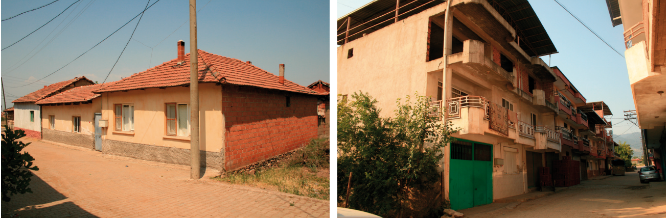
Resim 8. Betonarme karkas yapılar (Tandoğan, 2015)
