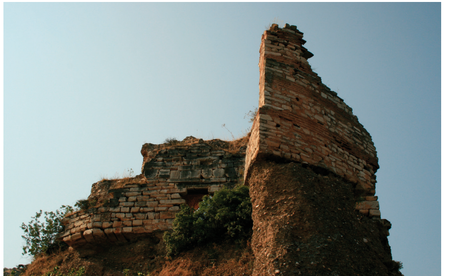
Resim 15. Akropol dış duvarları (Tandoğan, 2015).
