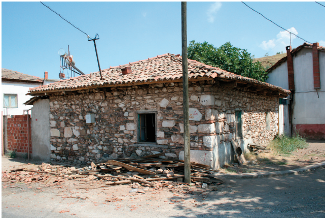
Resim 7. Yığma taş ve kerpiç yapı sistemi ile inşa edilmiş yerel konutlar (Tandoğan, 2015)
