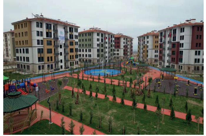
Gaziantep Islahiye Deprem Konutları
