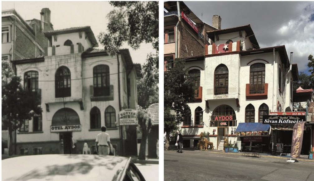
Figure 3.83. Aydos Hotel (left) (VEKAM Digital Archive, Taşınmaz Kültür Varlıkları Envanteri, TKV0454), Aydos Hotel (right) (Author, 2024)
