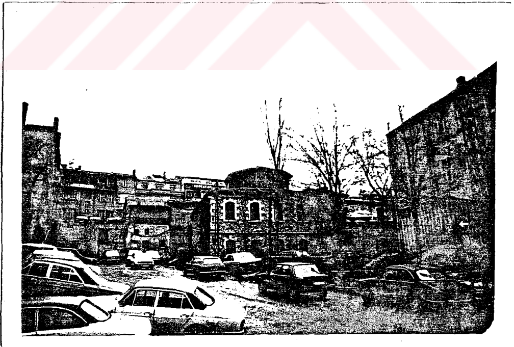
Photo.2 Acı Çeşme Sokağı (SE), (1987)
