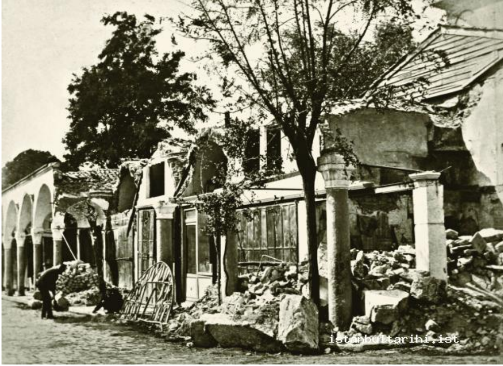
Figure 46. Direklerarası damaged during the Earthquake (source: İstanbul Atatürk Kitaplığı, “İstanbulda Vuku Bulan Büyük Hareket-i Arz’a ait Albümler”, Nr.184/2- https://istanbultarihi.ist/27-bir-sehir-manzarasi-istanbulun-tarihinde-depremler )
