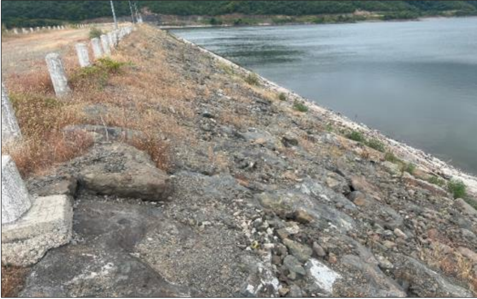
Figure 3.5 The upstream face of the Ondokuz Mayıs Dam (2023)
