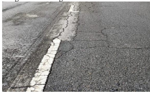
Longitudinal Cracking
