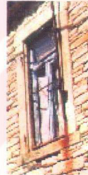
Figure 5.1.8 W01C3 Bayraktar Sokağı No:13
