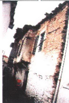
Figure 2.2.24 Orkun Sokağı . No:11-13
