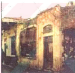
Figure 4.2.7 Shop Şirin Sokağı No:8
