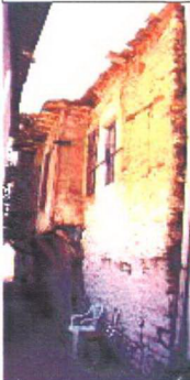
Figure 2.2.23 Orkun Sokağı No:13
