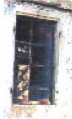
Figure 5.1.4 W01B2 Kaptan Sokağı No:7
