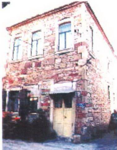
Figure 2.2.1 Hayat Sokağı No:1
