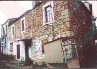
Figure 2.2.9 Günışığı Sokağı No:2-6
