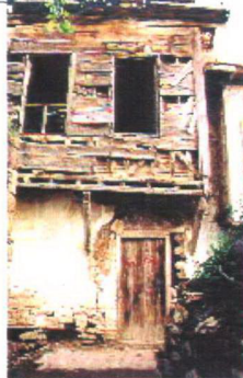
Figure 2.2.25 Orkun Sokağı . No:9
