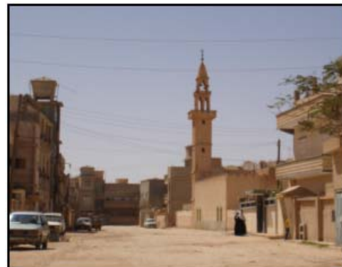
Figure 5.30: Um al-Kurra Mosque, Minaret
