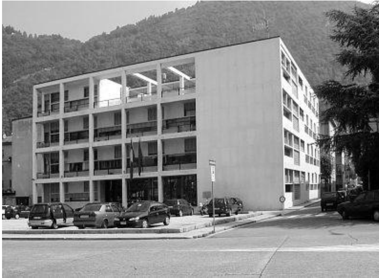
Figure 4-15: Casa del Fascio (now casa del Popolo), G. Terragni, Como, 1932-36
