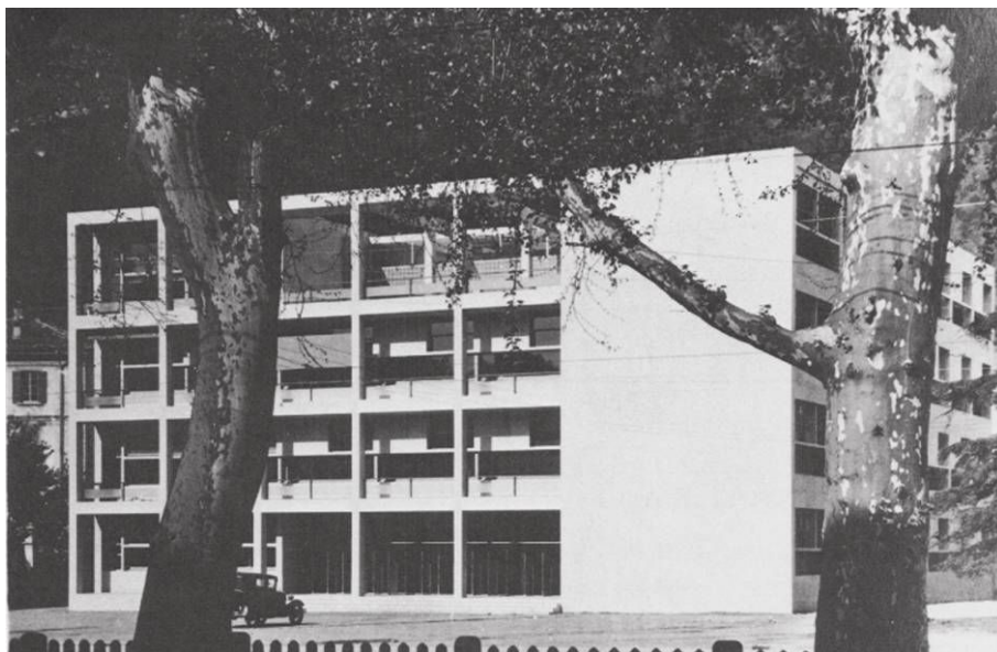
Figure 5.1: Casa del Fascio in Como by Giuseppe Terragni: facade
