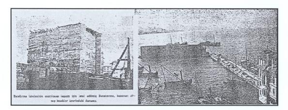
**Figure 3.13** Construction of Bandırma Pier. Right, the caisson in water; left, the caisson on wooden piles. Source: "Nafıa Haberleri", *BİD*, 1941, v.8/4, pp.74-78; "Liman ve İskelelerimizdeki inşaat faaliyetlerine umumi bir bakış", *BİD*, 1941, v.8/5, pp.73-79.
