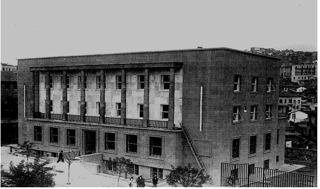
Figure 4.3: Emlak ve Eytam Bankası Umum Müdürlüğü Building
