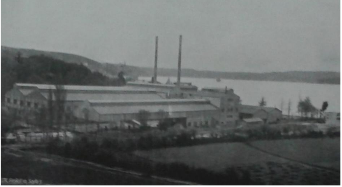
Figure 3.3a: Paşabahçe Glass Factory ( İş Bank contributed to its construction) Source: Cumhuriyetten Günümüze Kemal'in Türkiyesi, La Turquie Kemaliste, Boyut Yayınları, p.109
