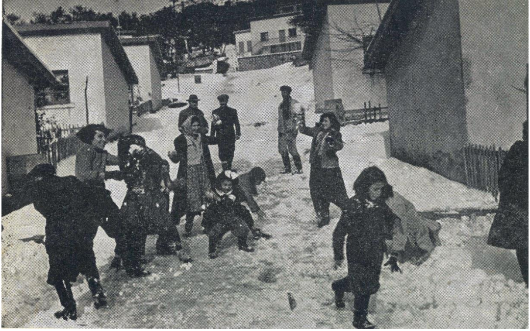
Figure 4.50 The site of the workers' housing project in Hereke. Source: Anon., İşçi Sigortaları Kurumu Nasıl Çalışıyor? .
