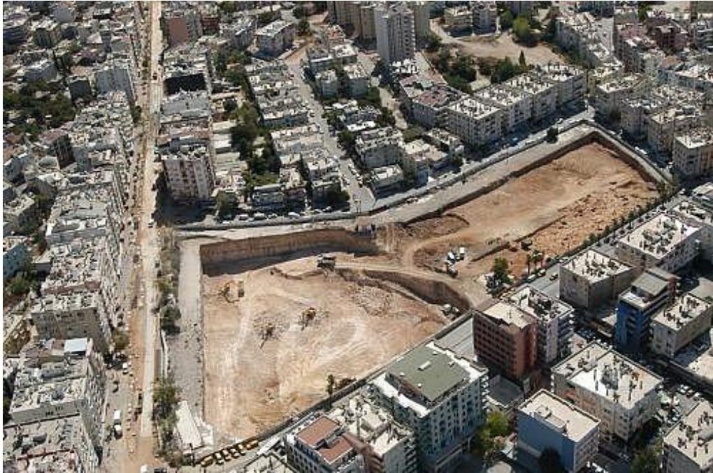
Figure 5 Present state of Antalya Doğu Garajı
