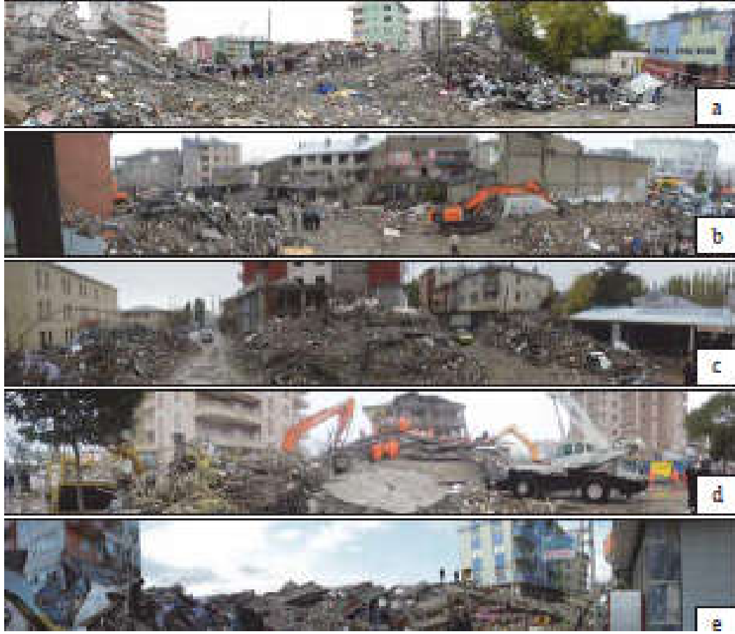
Figure 2.7 : Wrecked Buildings (23 Ekim 2011 Mw 7.2 Van Depremi Sismik ve Yapısal Hasara İlişkin Saha Gözlemleri, 2011)
