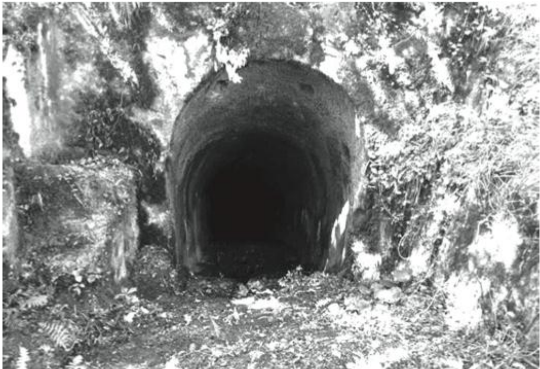
Rock-cut tunnel (Erol, 2013, 193).
