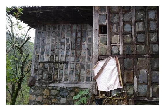
Figure 3.12. Dolma göz walls of Yolgeçen 15
