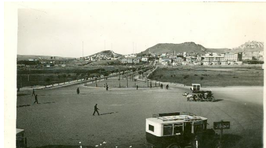
Figure 3.47.b: The loop at the end of İstasyon Caddesi , 1928.
