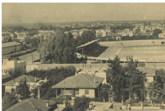
Figure 3.2. Adana City Stadium (Source: Adana'nın Eski Fotoğrafları Facebook Group)
