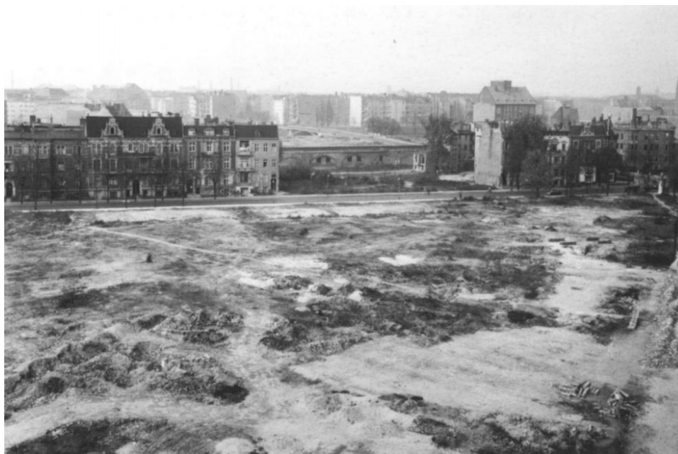
Figure 2.10. The Hansaviertel before reconstruction
