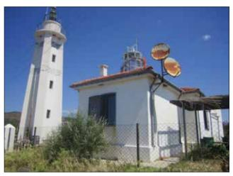
Figure 6. Sivrice Lighthouse in Ayvacık, Çanakkale had a light tower within the keeper's residence until 1945. Today it has an independent concrete light tower, (Başağaç 2012). / Çanakkale Ayvacık'ta bulunan Sivrice Deniz Feneri'nde ışık kulesi 1945 yılına kadar bakıcı konutu içerisinde yer almıştır. Bugün ise bağımsız beton bir ışık kulesi bulunmaktadır. (Başağaç 2012).
