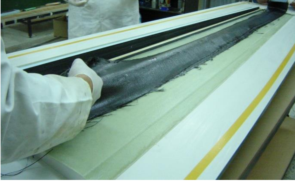
Şekil E-22 Kiriş yapısını oluşturan karbon kumaşların kiriş kalıpları üzerine serilmesi
