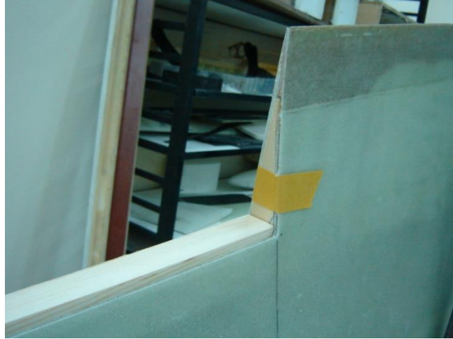
Şekil E-55 Kanatta kalan boşlukların tahta blok ve yapıştırıcı ile doldurulması
