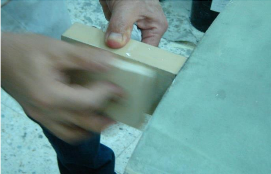
Şekil E-44 Kiriş köküne çelik macunu uygulanarak pürüzsüz hale getirilmesi
