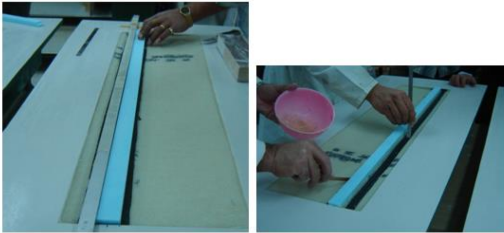
Şekil E-90 Yatay Kuyruğun Ön Kiriş İç Nüve Malzemesi Olan Uygun Ebatlardaki Mavi Köpüğün Alt Kabuk Üzerine Yerleştirilmesi Ve Kenarlarından Alt Kabuğa Yapıştırılması
