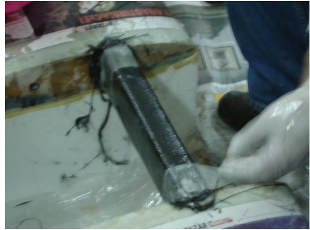
Şekil E-48 İslatılmış karbon kumaşların kirişlere sarılması (solda), Cam elyaf şeritlerin sarılması (sağda)
