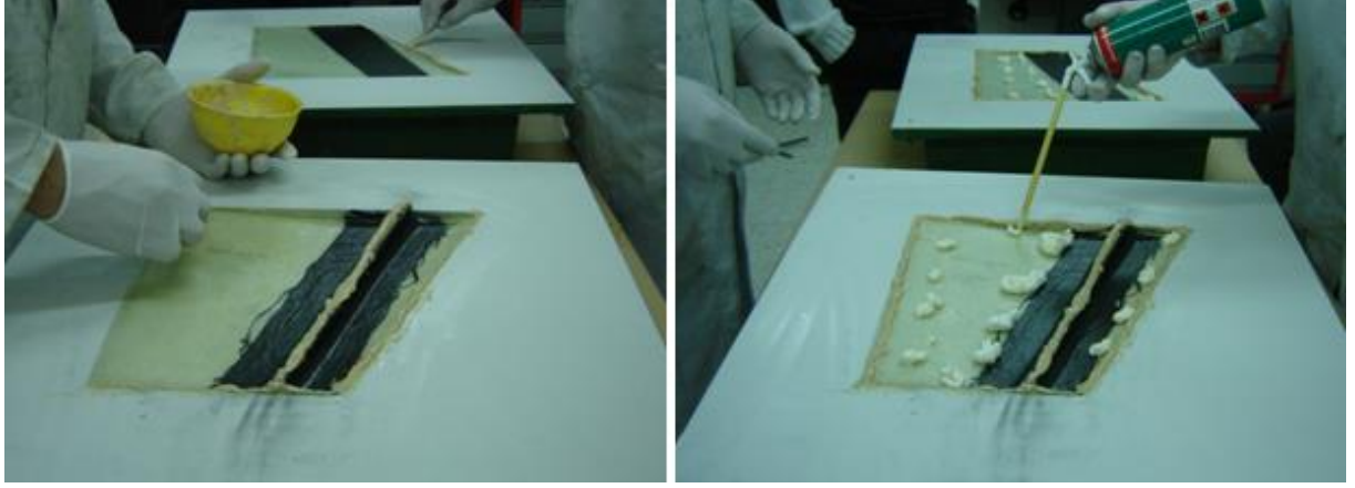
Şekil E-100 Dikey Kuyruk Kabuklarının Birleştirilme İşlemi
