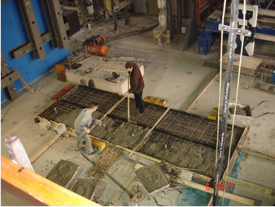
Şekil 123 – Binanın temel ve çatı döşemesinin dökülmesi.
