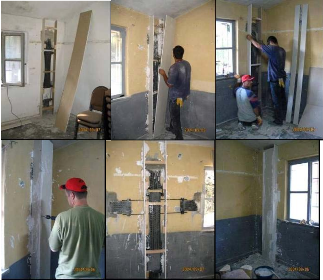
Şekil 164 – Alçıpan ile iç yüzeylerin kaplanması.
