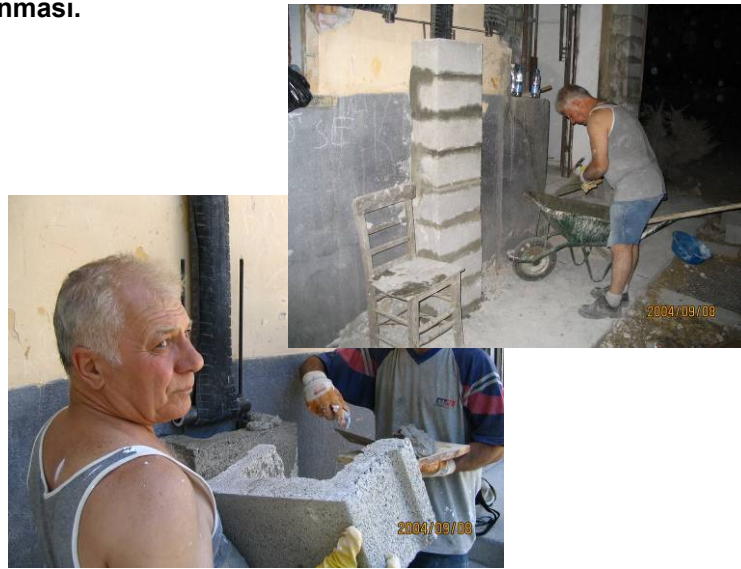
Şekil 166 – Dış yüzeylerin içi oyulmuş U-şekilli briket ile kapatılması.
