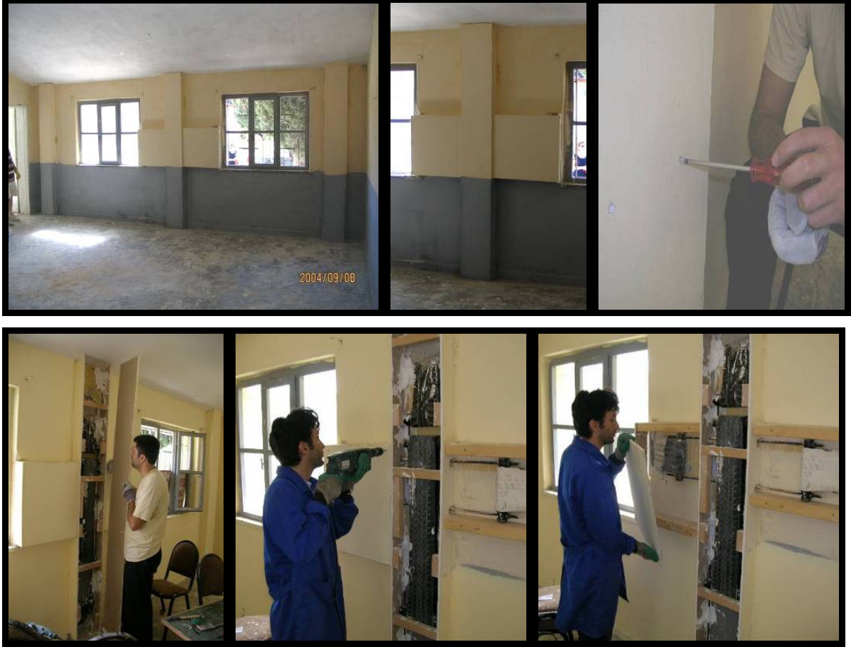
Şekil 167 – İç duvarlarda bulunan alçı panoların açılması
