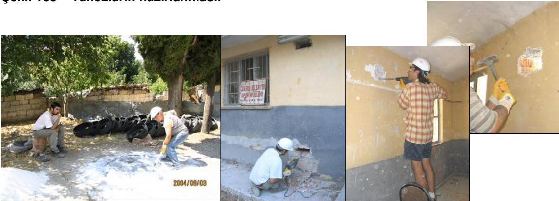
Şekil 159 – Duvar deliklerinin delinmesi.
