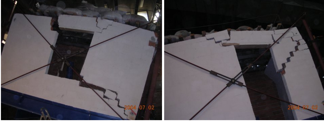
a) Ana duvarlar üzerinde oluşan çapraz çatlakların dağılımı
