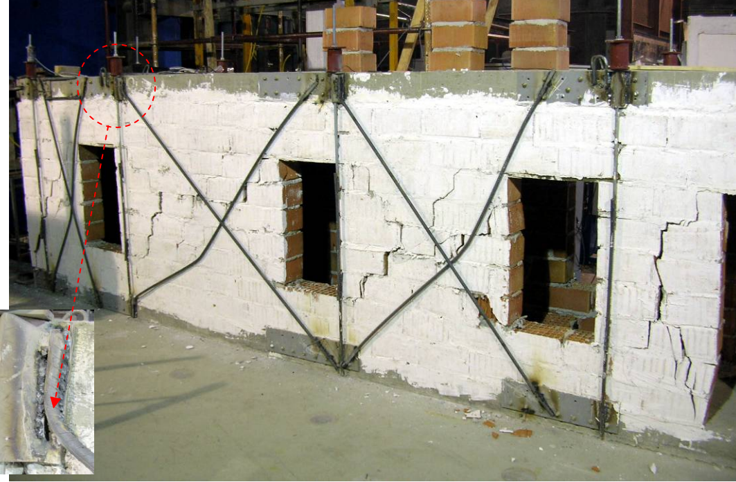
Şekil 149 – Düşey gergi ve çapraz elemanlar ile güçlendirilen deneyi, çapraz elemanların akması ve burkulması.
