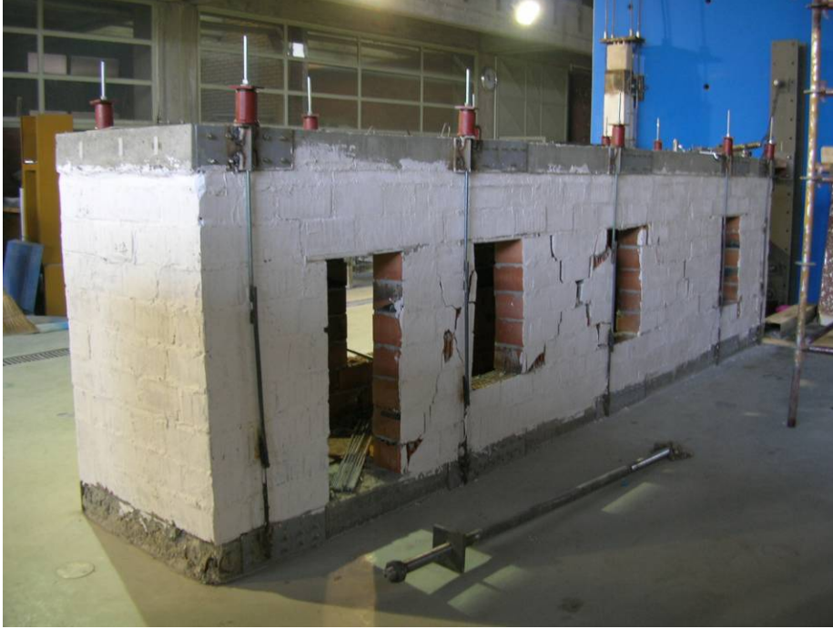
Şekil 143 – Düşey gergili test, diyagonal çatlakların oluşumu
