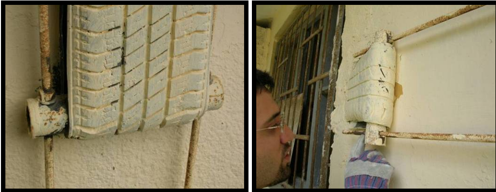
Şekil 170 – Vitrin ve inceleme amaçlı olarak açığa bırakılan gergilerde gözlemlenen paslanma başlangıcı
