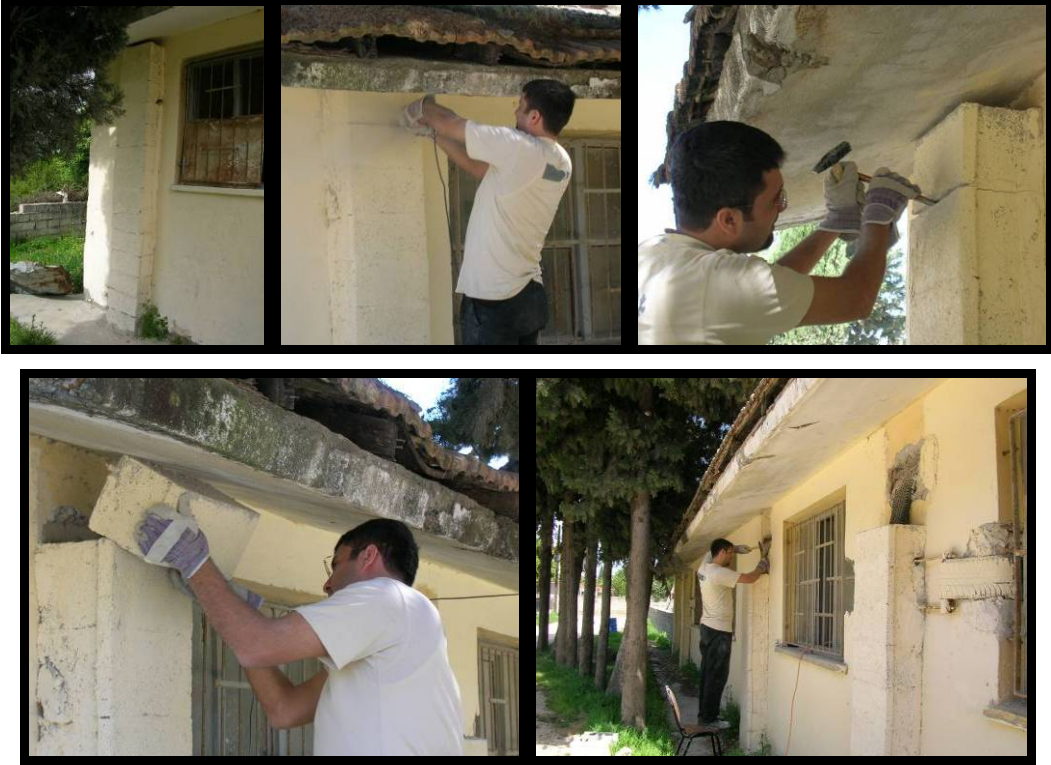
Şekil 168 – Dış duvarlarda bulunan “U” şekilli briket kaplamanın açılması
