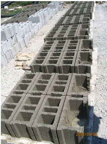
Şekil 166 – Dış yüzeylerin içi oyulmuş U-şekilli briket ile kapatılması.
