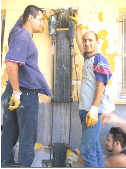
Şekil 163 – Somunların sıkılması (zaman aldığı için lastik boşluğu matkap ile gerdirme elle yapıldı).
