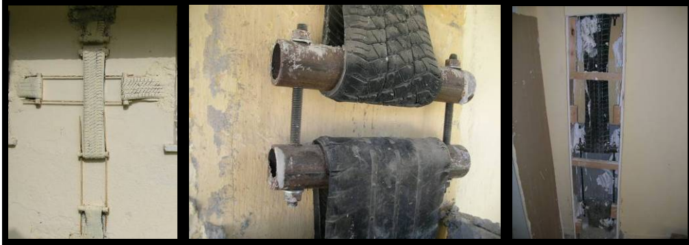
Şekil 169 – Lastik gergilerin gözlemlenen genel durumu
