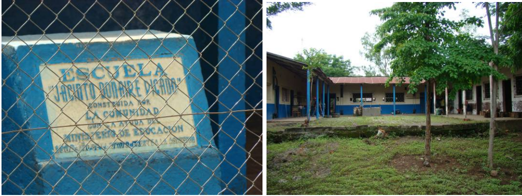
Şekil 172 – Nikaragua, León'da güçlendirme çalışması yapılan okul binası
