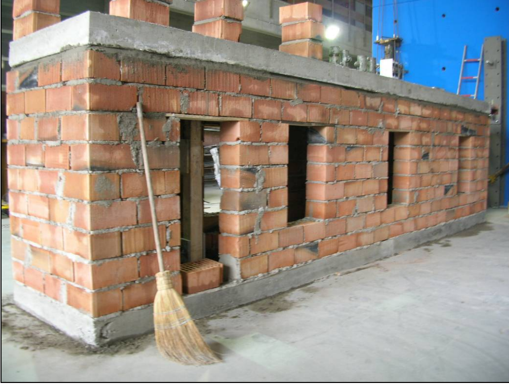
Şekil 126 – 6m ev bitmiş hali genel görünüm.
