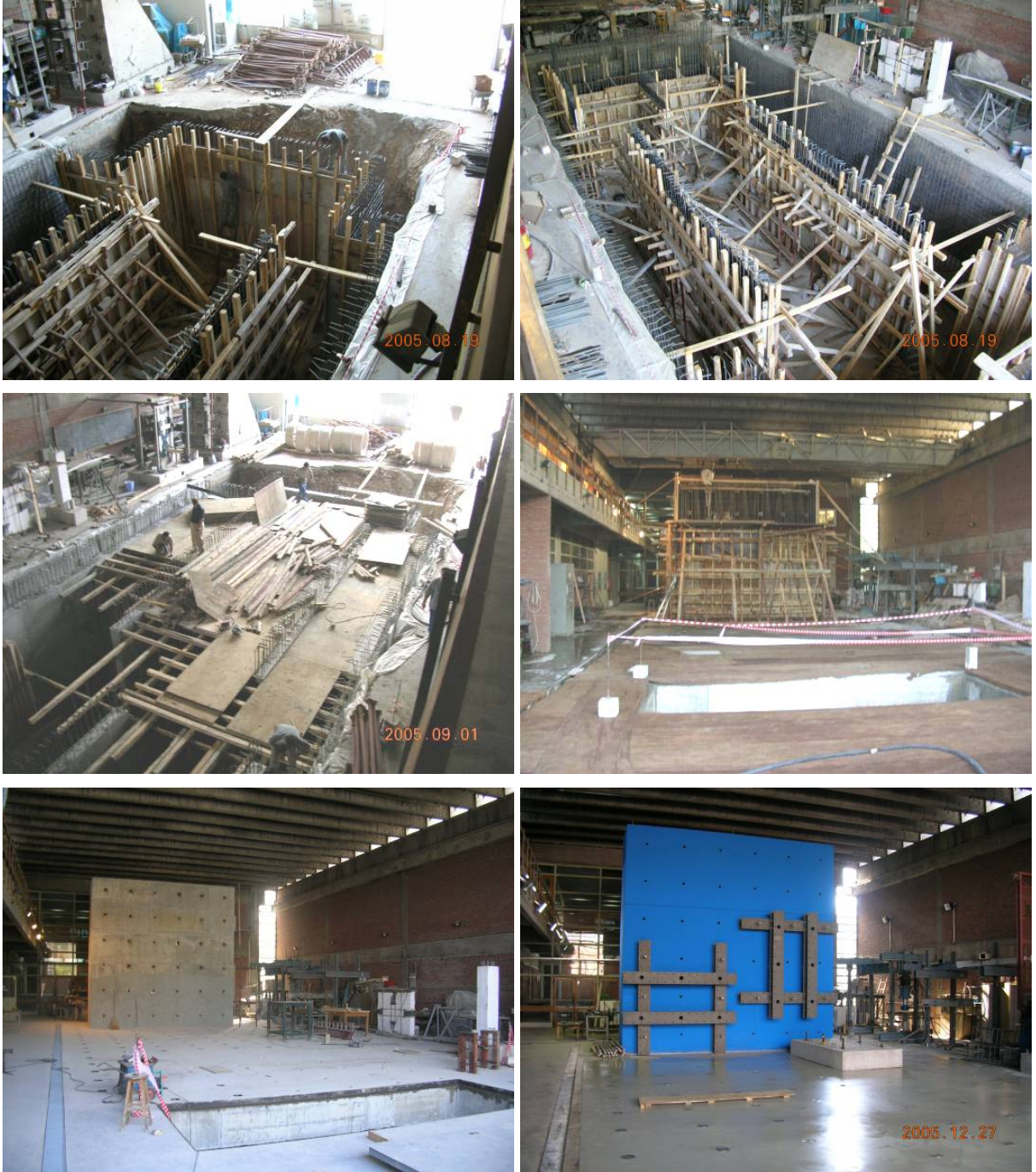
Şekil 197 – Laboratuvarda yapılan alt yapı çalışmaları
