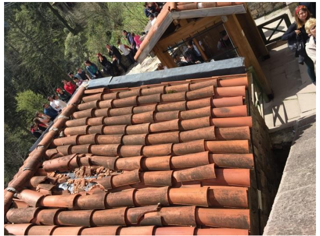
Şekil 7.3. Bilet gişesi binasının çatısında kaya düşmesi nedeni ile meydana gelen hasarlar
