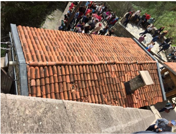
Şekil 7.3. Bilet gişesi binasının çatısında kaya düşmesi nedeni ile meydana gelen hasarlar
