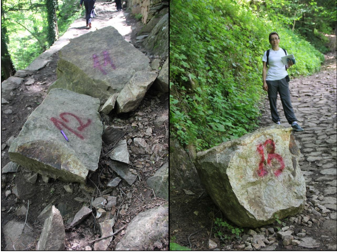
Şekil 7.6. Patika yolda bulunan düşmüş kaya blokları
