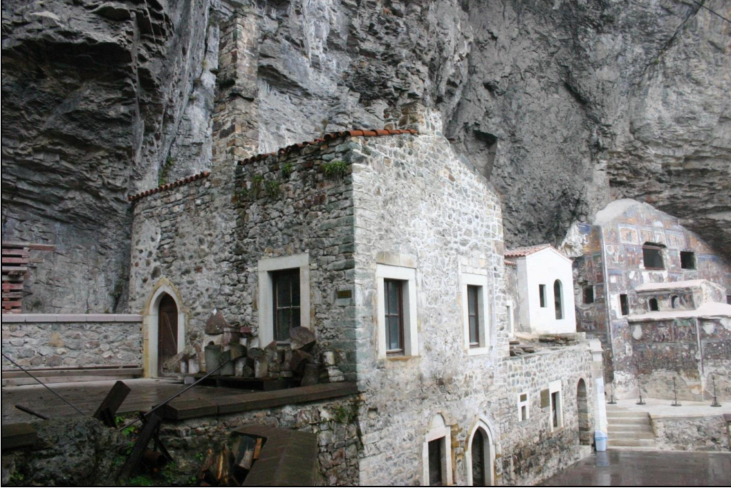
Şekil 2.5. Yemekhane olabilecek yapının duvarı önündeki düşmüş taşlar, (Yavuz (2007)'den alınmıştır).
