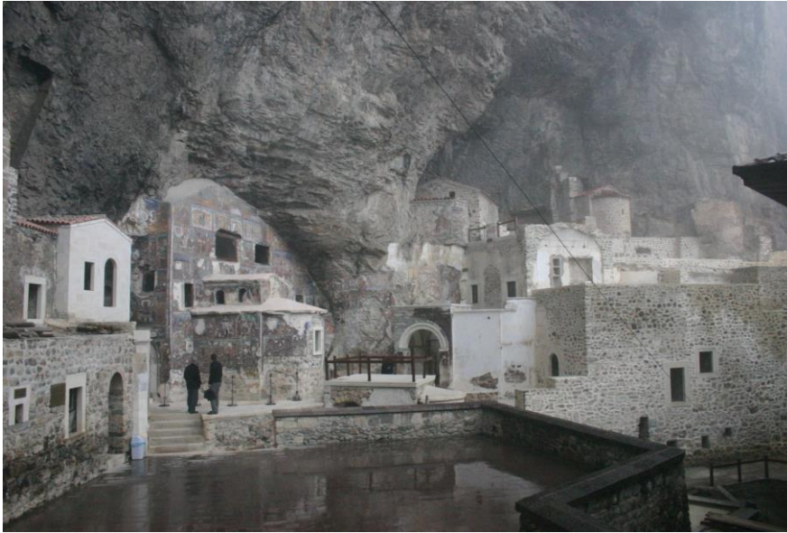
Şekil 2.3. Mağara kilisenin etrafındaki yapılaşma ve onarımlar, (Yavuz (2007)'den alınmıştır)
