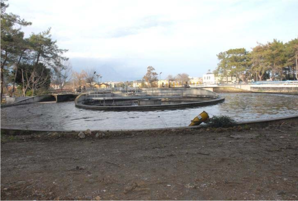
Şekil 2.25. Kemer 2 Tesisi mekanik havalandırmalı Pasveer türü oksidasyon hendeği ve ortada daire kesitli son çöktürme tankı
