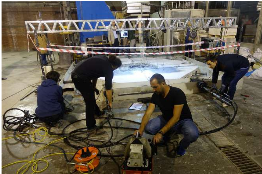
Şekil 3.62 Öngerme uygulaması. Aynı anda iki halata öngerme uygulanarak meydana gelecek dönme etkisi minimize edilmiştir.
