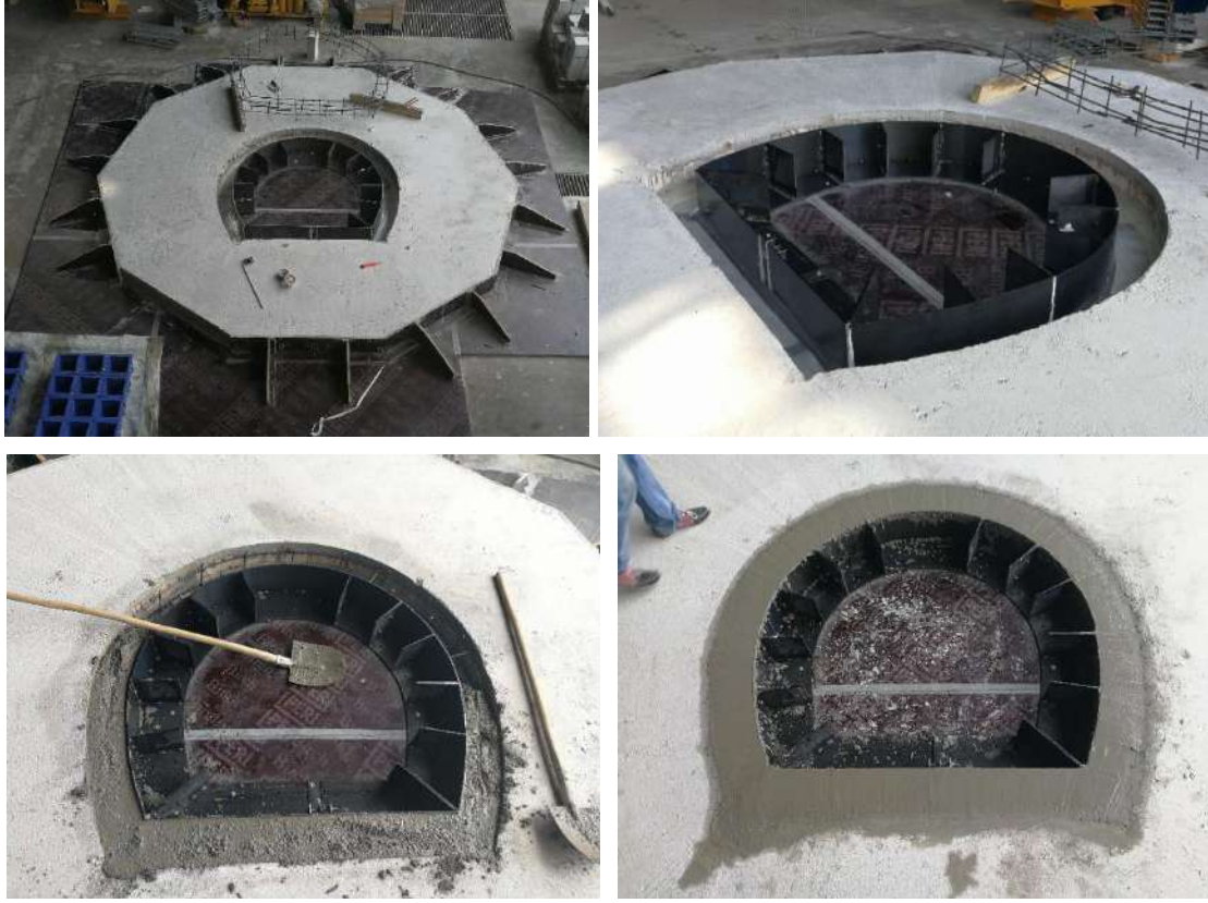
Şekil 3.9 Kaplama donatısının yerleştirilmesi.
