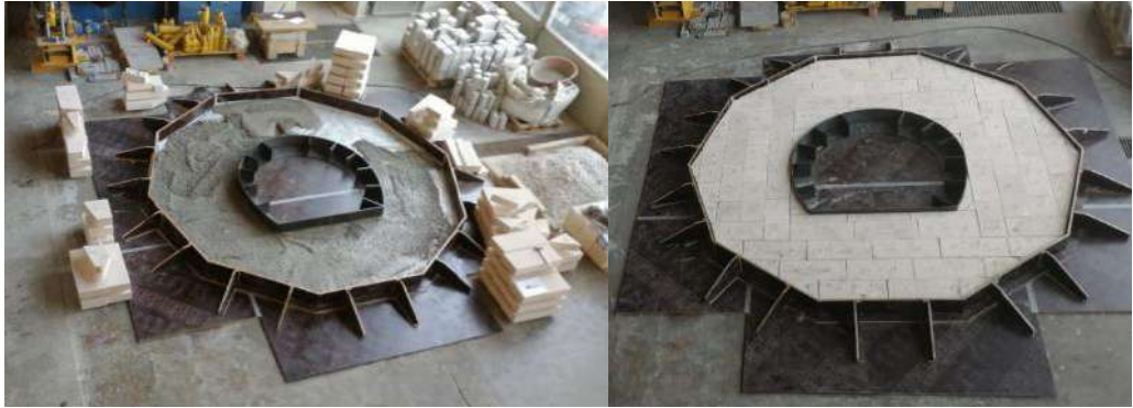
Şekil 3.5 Alt beton katmanın dökümü ve gazbeton blokların beton katman üzerine yerleştirilmesi.
