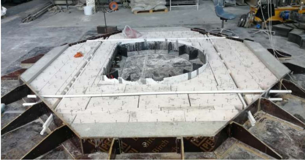
Şekil 3.53 Üst beton katmanının dökümünden önce yapılan hazırlıklar.
