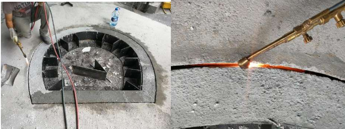
Şekil 3.54 Tünel kaplamasının öngerme esnasında yük almasını engelleyecek boşluğun oluşturulması.
