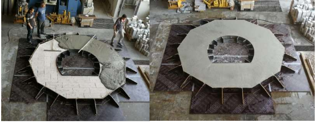
Şekil 3.6 Üst beton katmanın dökümü.
