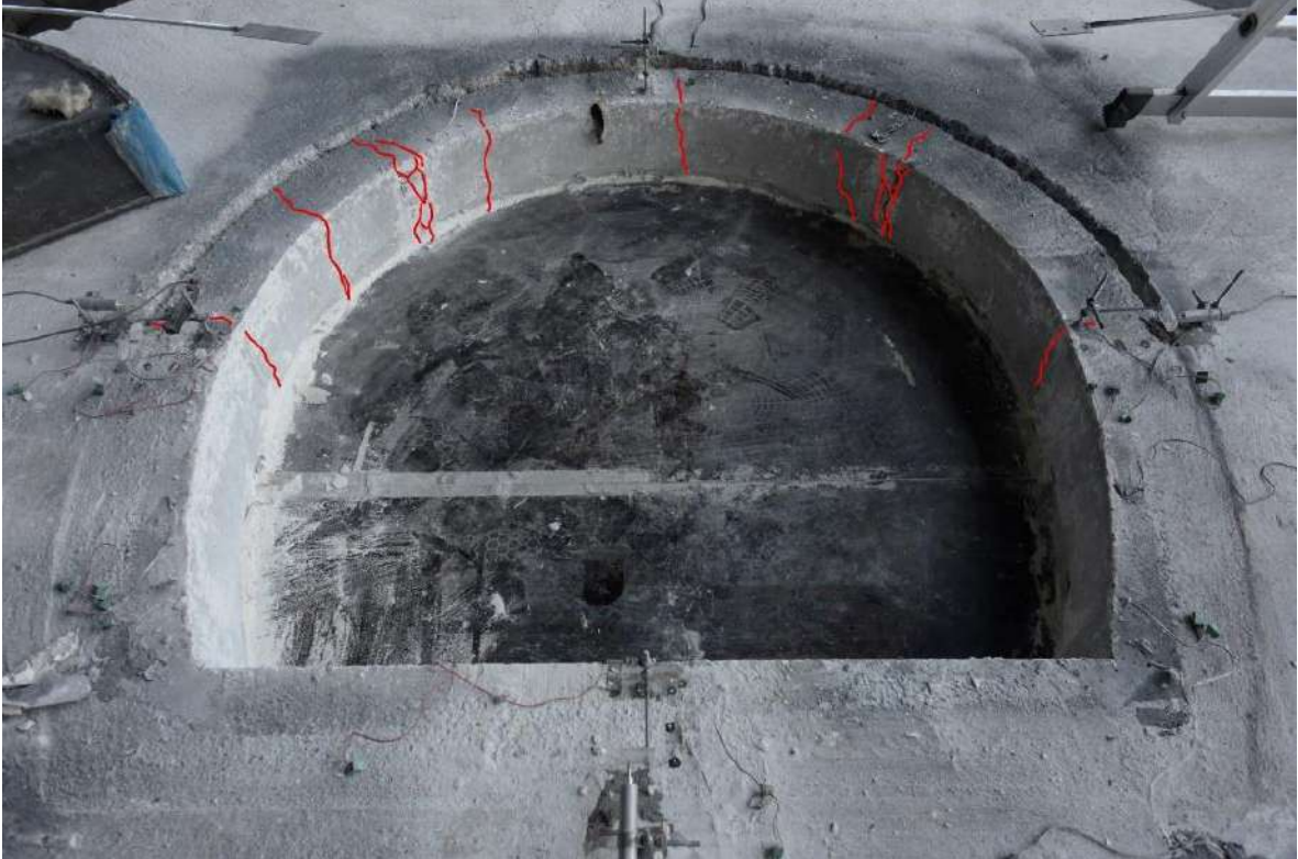
Şekil 3.88 Yeni oluşan çatlak yerleri ve oluşum sırası (dördüncü deney).
