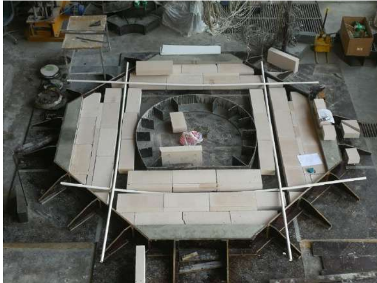
Şekil 3.51 Yaslanma betonu döküldükten sonra yapılan hazırlıklar.
