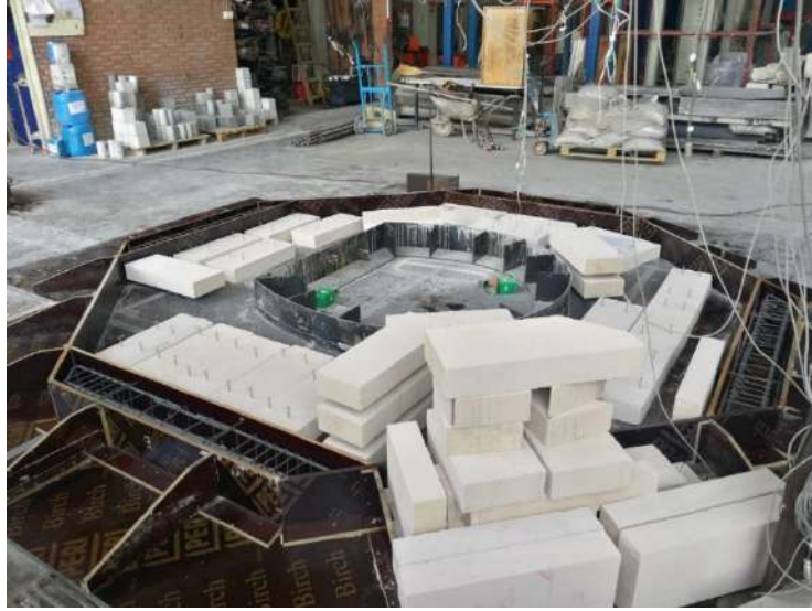
Şekil 3.50 Sekizgen kalıp ve yaslanma betonu donatısı.
