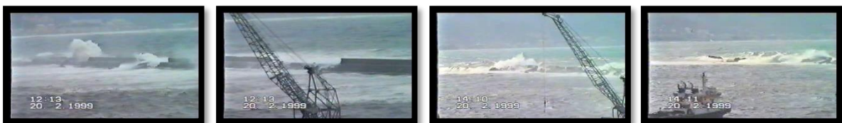
Şekil 4.5. 1999 fırtınası sırasında Giresun Limanı ana mendireğinin yıkılış görüntüleri
