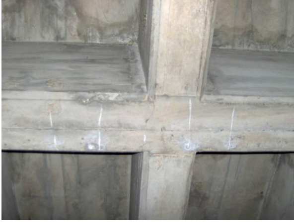
Şekil 86 – Ultrasonik okuma derinliğinin ölçülmesi, pilot uygulamalar.
