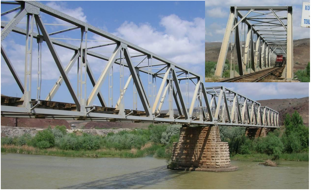
Şekil 82 – Üç açıklıklı makas tren yolu köprüsü, dinamik ölçüm çalışmaları.
