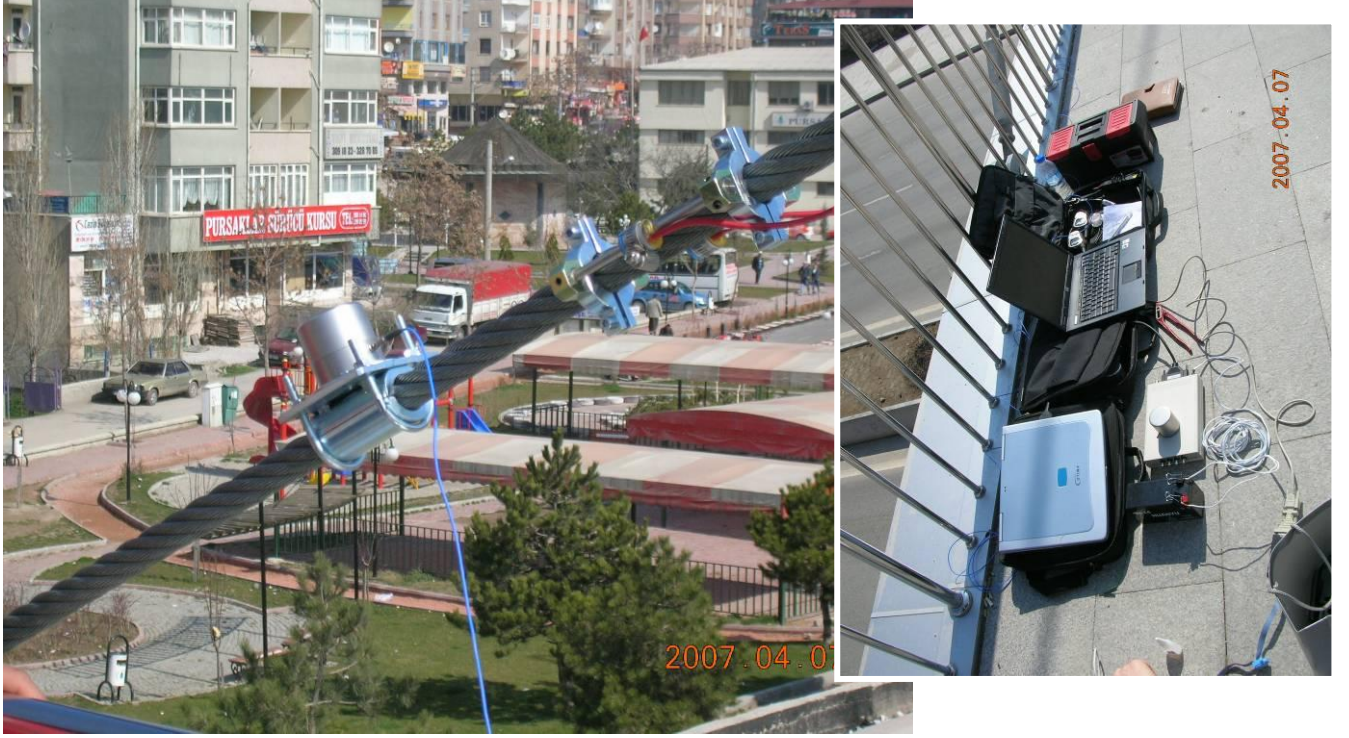
Şekil 66 – Kablo titreşim ve birim deformasyon (şekil değiştirme) ölçümleri yapılması.
