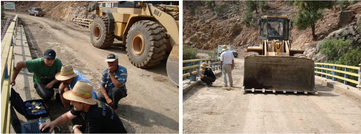
Şekil 128 – Köprü üstüne yerleştirilen ivme ölçerler ve kepçe ile vurularak dinamik test yapılması.
