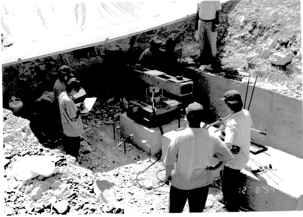
Şekil E1.1 Deney Yerinde (km 12+100) Formasyonun Görünüşü
