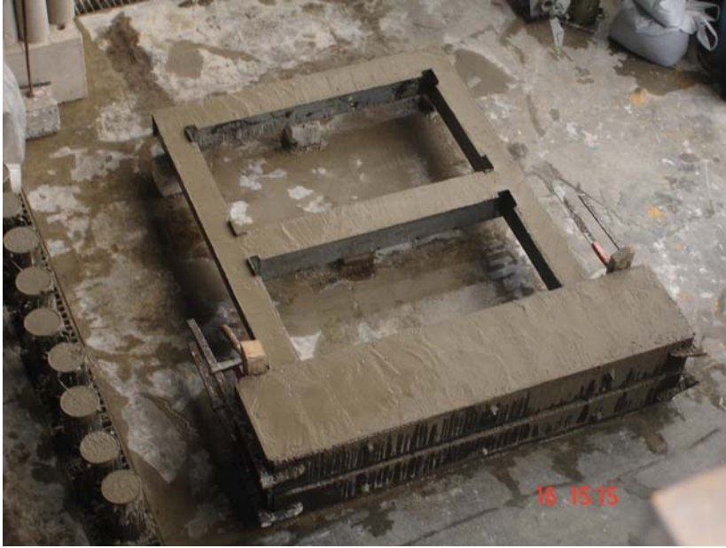
Şekil 51 Çerçeve Elemanı Beton Döküm Sonrası Görüntüsü
