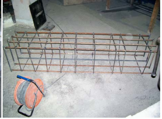
Temel Kirişi Donatı Görünümü
