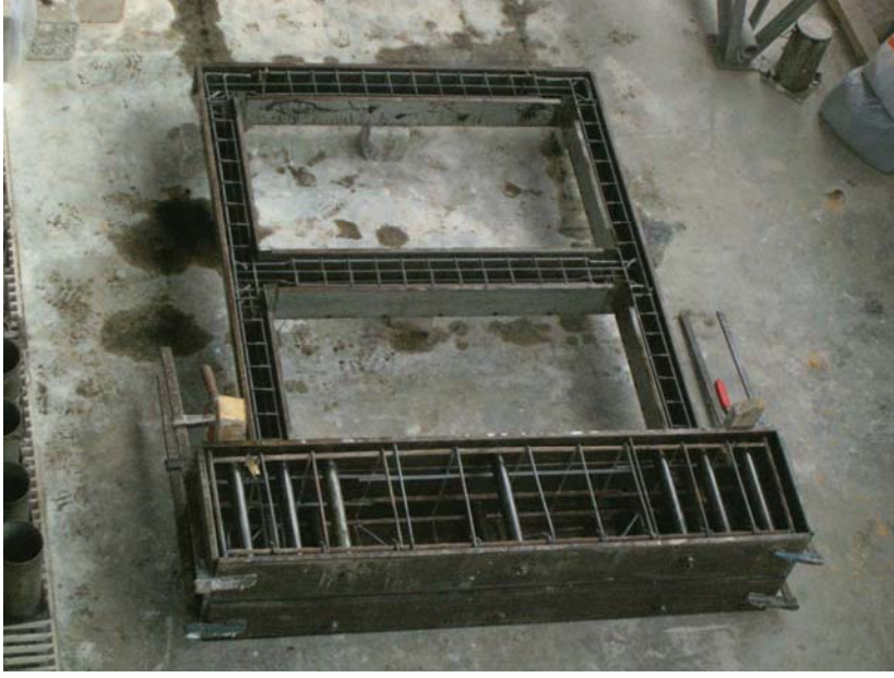
Şekil 50 Çerçeve Elemanı Beton Döküm Öncesi Görüntüsü
