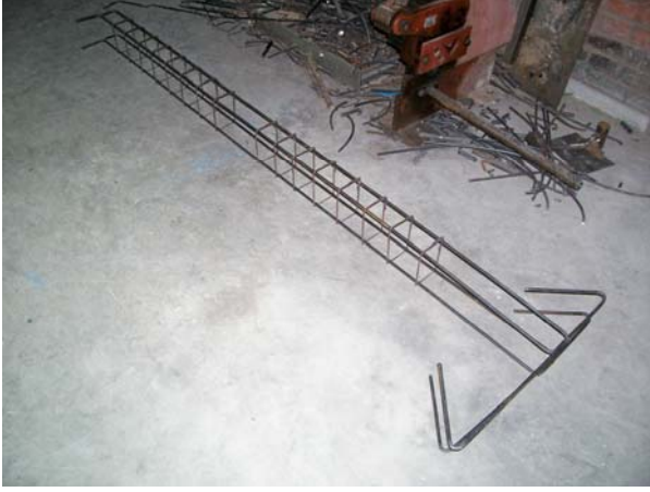
Kolon Donatı Görünümü
