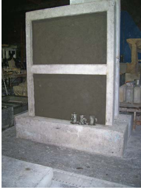
Şekil 56 Çerçeve Eleman Polipropilen Fiber İçeren Harç Kullanılarak Güçlendirme İşlemi Görüntüsü
