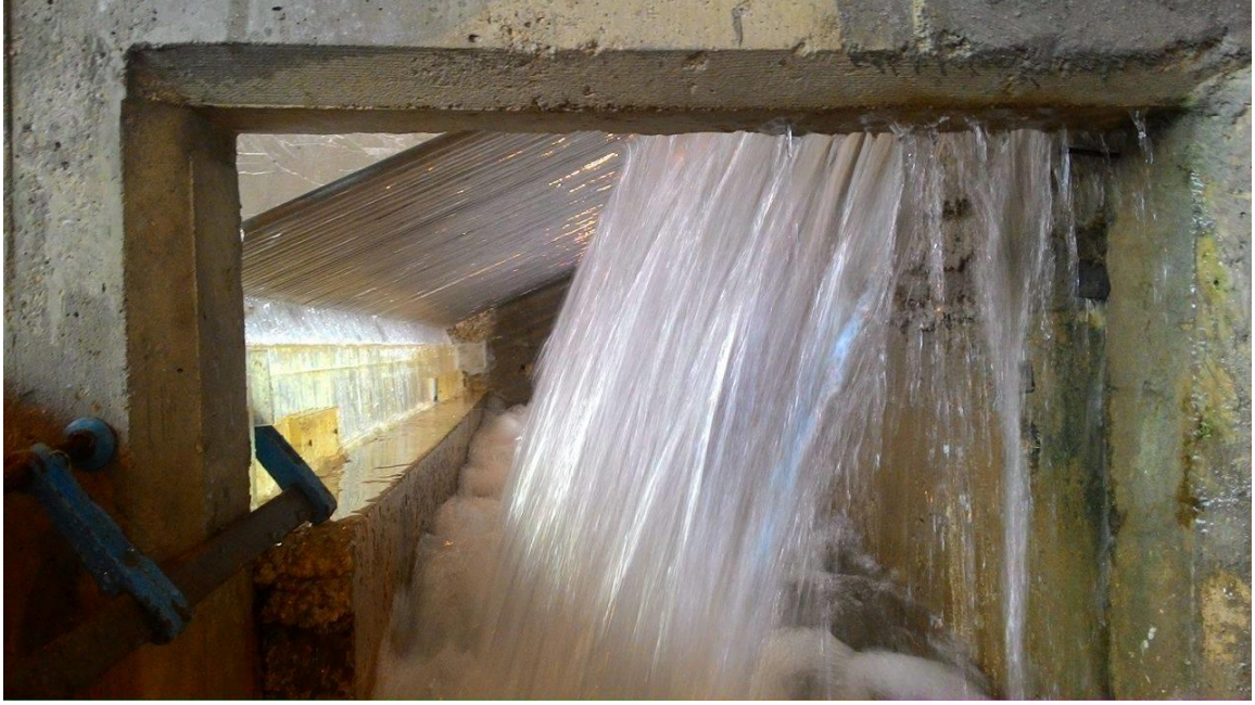
Şekil 2.6 Su toplama kanalı ve ızgaranın yandan görünümü
