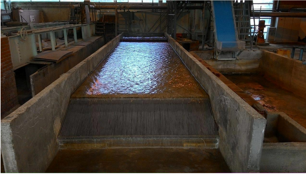
Şekil 2.4 Ana Kanal ve Tirol tipi savağın mansap kısmından görünümü
