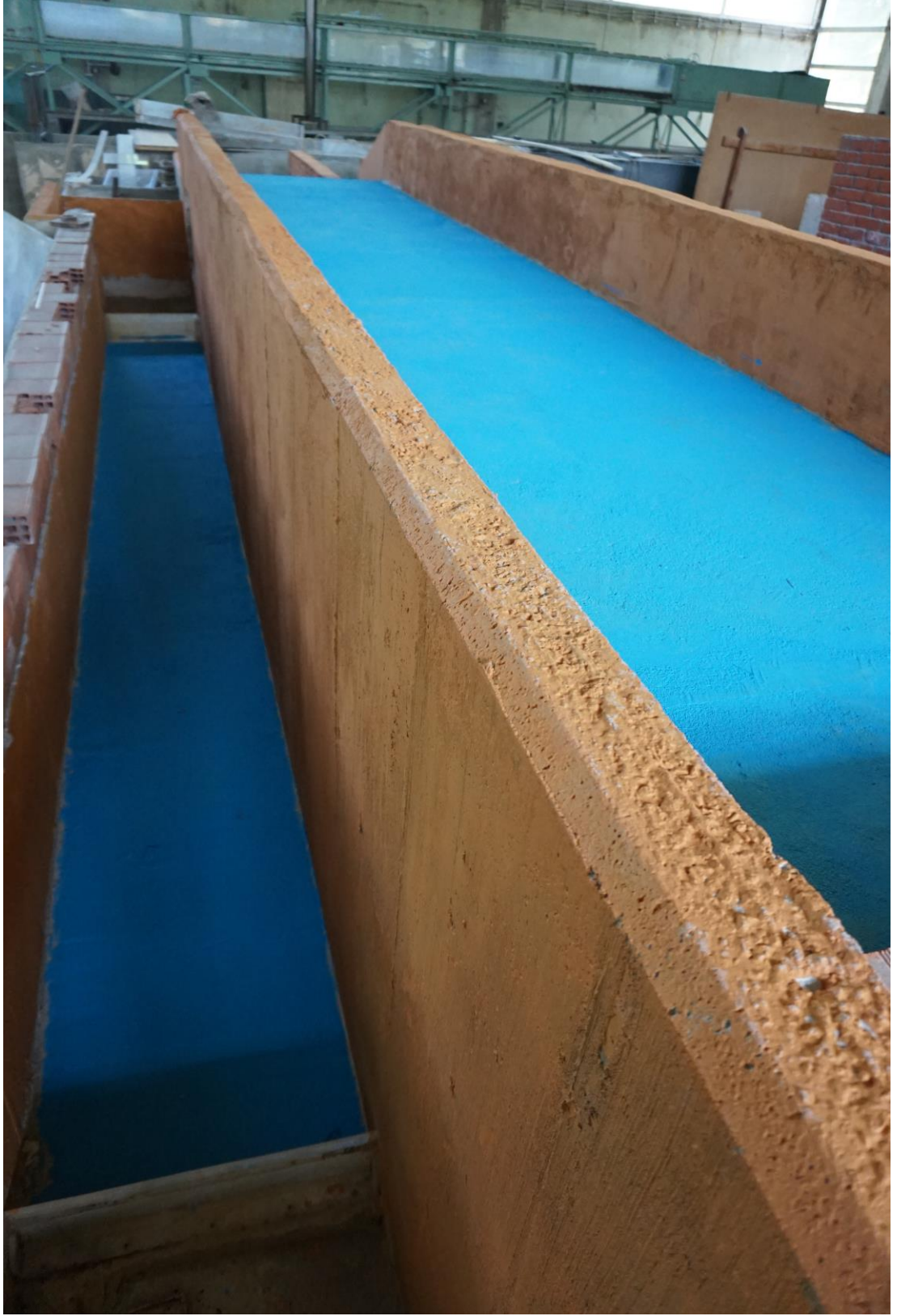
Şekil 3.6 “Su alma kanalı” nın mansaptan görünüşü
