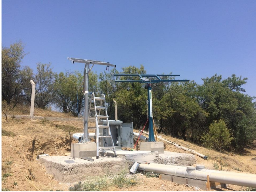
Şekil 3-1. Güneş Takip Mekanizmaları
