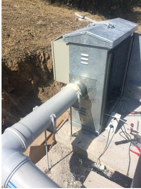
Şekil 3-2. Veri toplama kanallarının trafo kutusuna bağlantı detayları
