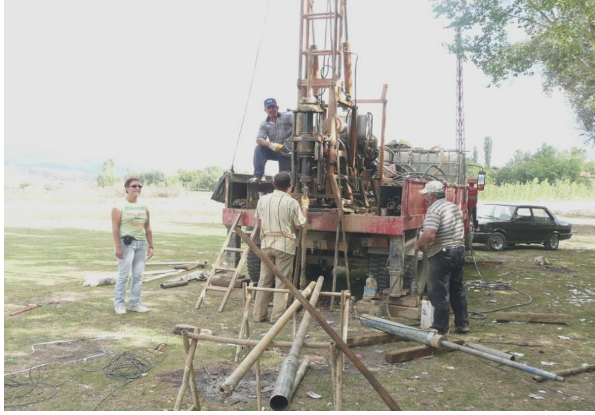
Şekil 3.6.Çalışma alanında yapılan sondaj çalışmaları.
