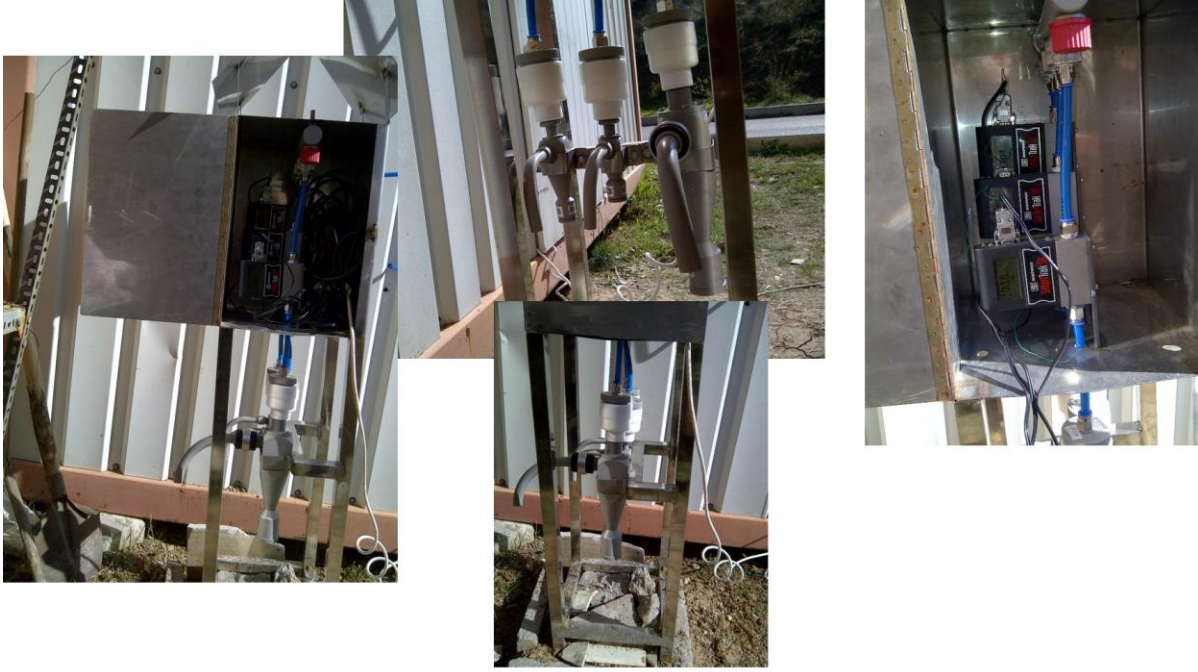
Şekil 34 Örnekleyicinin geçici kabine yerleştirilmiş hali
