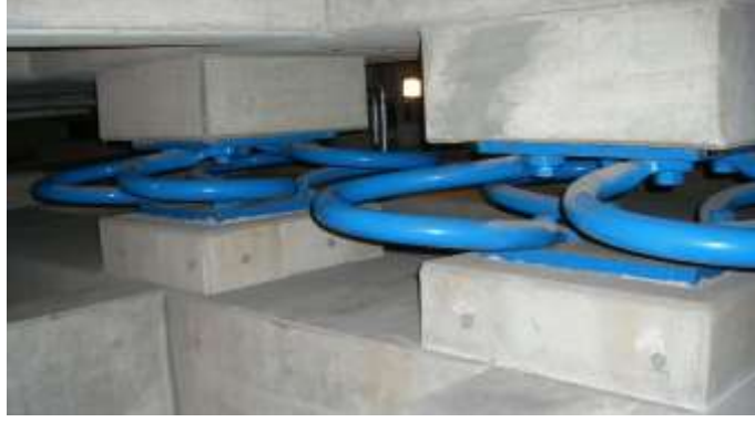
Şekil 1-10. Kauçuk mesnetler ve sargı şekilli elasto-plastik damper Fotoğrafta Tokyo'daki bir uygulaması gösterilmiştir. ( http://www.flickr.com/photos/goemon/1399271700/sizes/o/in/photostream/ , retrieved in July 16, 2013.)
