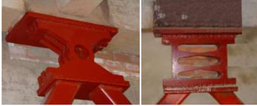
Şekil 1-5. Yapı çerçevesine yüklenmiş yuvarlak-delikli ve çift X-şekilli damperler (Li & Li, 2007).
