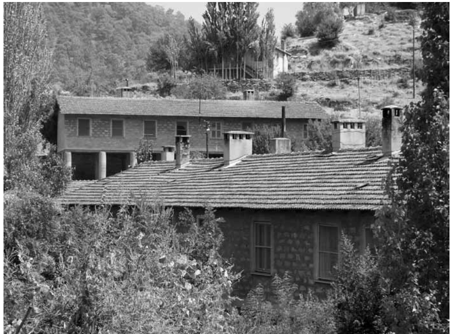
Resim 6. Kemer Barajı, Aşağı Site (Fransız Sitesi). Fotoğraf yazara aittir.
