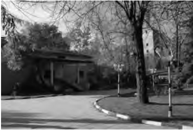
Resim 30. Lokanta, Ön Cephe.
