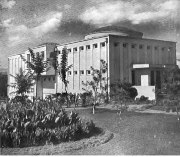
Resim 23. Bira Fabrikası Hamamı Genel Görünüm (Anonim. 1939).
