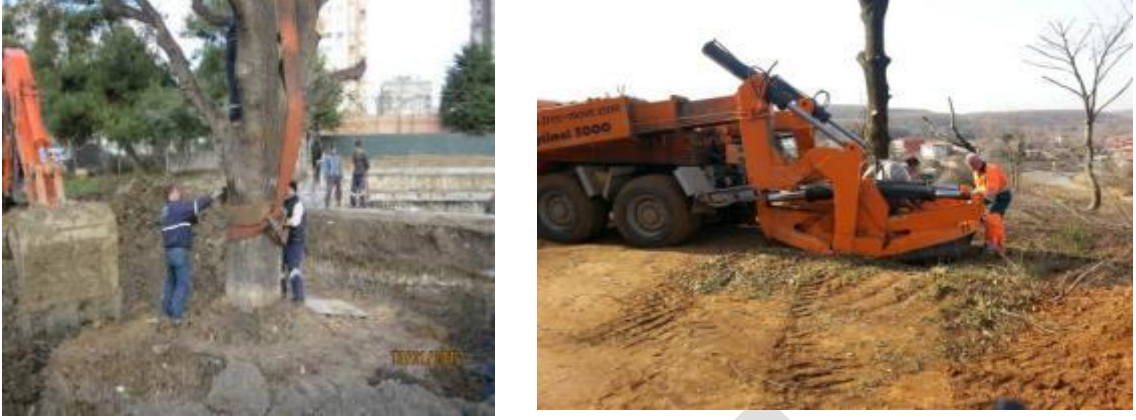
Şekil 1. Ağaç taşıma çalışmalarında kazı işlemleri, ağaçların sökülmesi ve köklerin korunması (URL-1)
