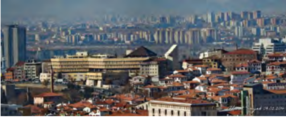
Şekil 4: Altındağ Belediye Binası
