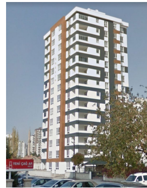
Figure 8. Residential building (D) ( https://earth.google.com , 2020).
