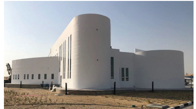
Görsel 12: Apis Cor, Dubai üç boyutlu yazıcı ile üretilen ilk çok katlı yapı ( https://www.3dnatives.com/en/apis-cor-largest-3d-printed-building-261020194/ ) (ET:02.06.2020)
