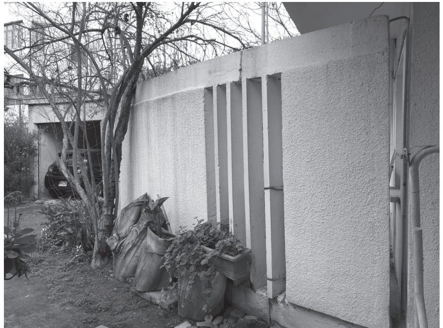
Resim 12. Ön cephede uzayan duvar. (Meray Taluğ'un arşivi)
