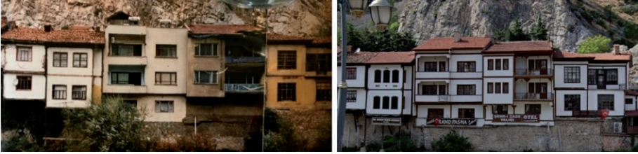
Şekil 23. Yalıboyu Cephesi, 1990lar -2021, Cephedeki yeni ve eski tüm yapılar son dönemdeki restorasyon uygulamaları ile aynı renge boyanmış ve bu restorasyon uygulamalarında aynı renk ve malzemeden doğramalar kullanılmıştır. (Sol, ODTÜ, Kültürel Miras Koruma Lisansüstü Programı, 1999 2000 Bahar Dönemi REST 507: Planning and Design in Urban Conservation, Amasya Hatuniye Mahallesi Koruma ve Sağlıklaştırma Projesi, Sağ, https://www.google.com/earth/ , 2021)
