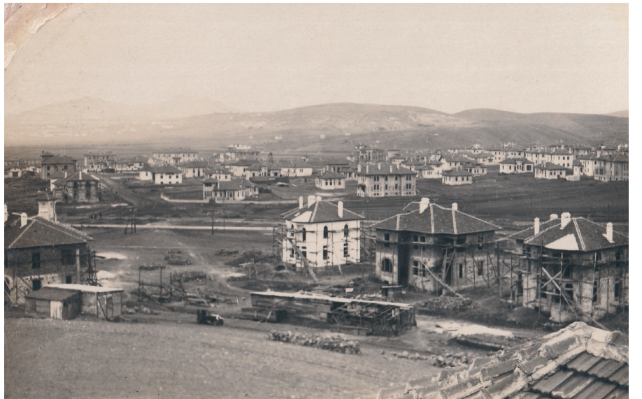
Resim 23. Yeni Şehir dokusu ortaya çıkıyor; karşıda Tuna ve Selanik Caddeleri beliriyor; önde İzmir Caddesi üzerindeki inşaatlar; arada Atatürk Bulvarı; 1926 yılı. (Cengizkan ve Cengizkan, der., 2019, 196, KÖA Yeni Şehir 31)
